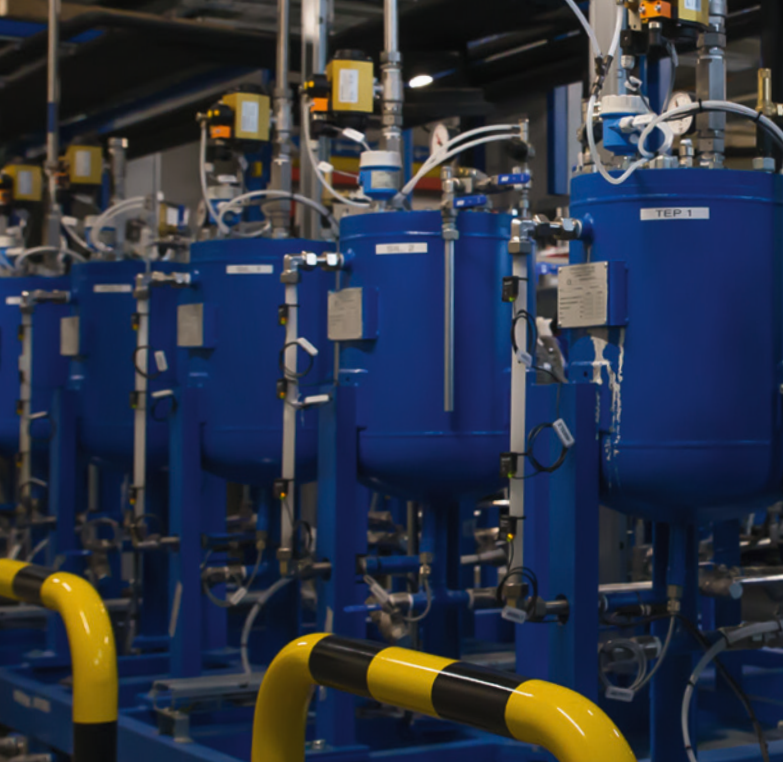
Mit 12 Pumpen werden alle Komponenten der Rezeptur von swissporPUR (PIR) präzise gemischt.
