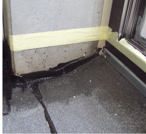
Betonpfeiler bei Loggias mit Wand und Fensteranschluss vorbereitet für Abdichtungsanschluss mit West Wood Wecryl 230 thix. Der Übergang von Betonpfeiler zu Fensterrahmen wurde mit Wecryl Spachtel 810 ausgefüllt.
