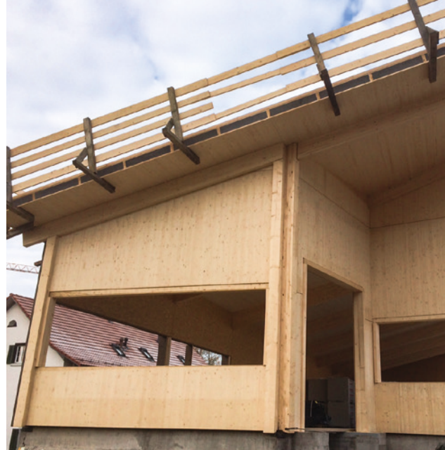
Aufgerichtete Wand- und Dachelemente
