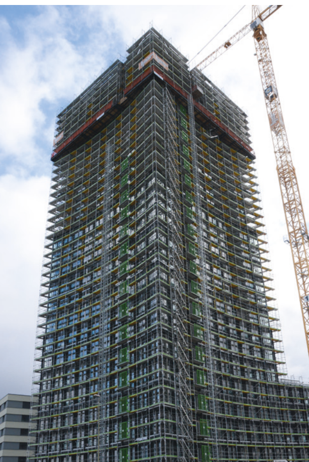
Ansicht CERES Tower während Bauphase von Kreisel Hohenrainstrasse aus
