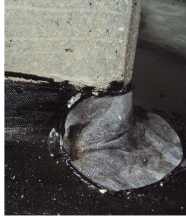
Eckausbildung bei Aufbordung zu erster Abdichtungslage
