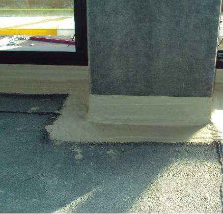
Abdichtung Loggia mit Flüssigkunststoff fertig ausgeführt
