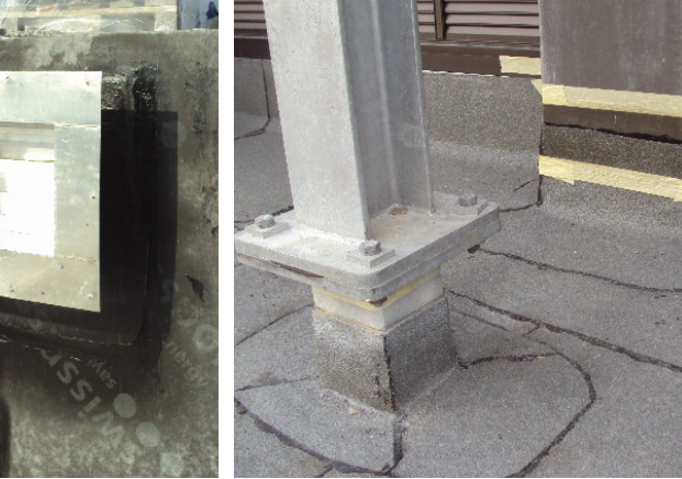
Stahlstütze von Rückkühlagregat und Betonpfeiler bituminös abgedichtet und vorbereitet für Flüssigkunststoffanschluss
